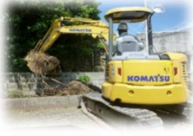
◇ 草置き場除去作業の様子
